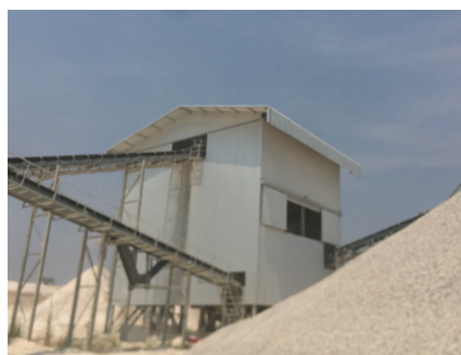
รูปที่ 2-20: การปิดคลุมอาคารโรงโม่
