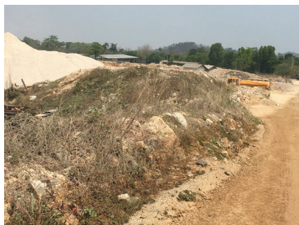
รูปที่ 2-9: คันทำนบกั้นดินทางตอนใต้ของลานกองแร่
